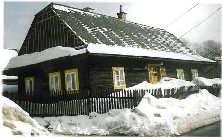
Roubený dům Hruškových, stav po obnově
